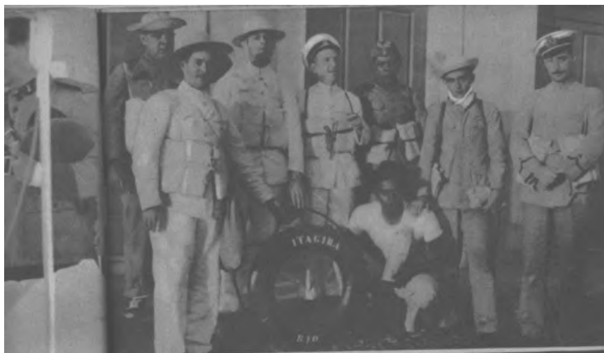
Foto 11: sobreviventes do Itagiba, portando equipamentos de salvatagem de que se utilizaram, em Valença-Bahia.
