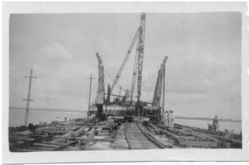
Jaraguá Antigo cód. A. 6. Foto nº 00007. Construção do Porto de Jaraguá na dec. de 40.
